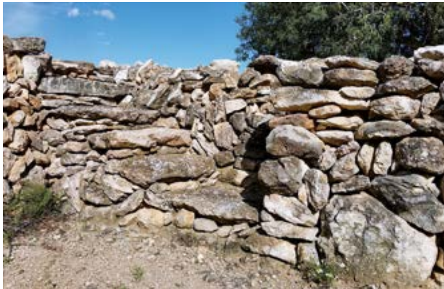
Marge de pedra seca, partida els Boverals, Mont-roig del Camp, 2022. Fotografia: Joan Rom.
